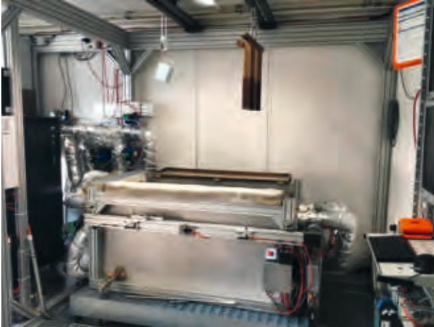
Abb. 4: Hochtemperatur-Teststand mit Latentwärmespeicher. (Quelle: Hochschule Esslingen)
