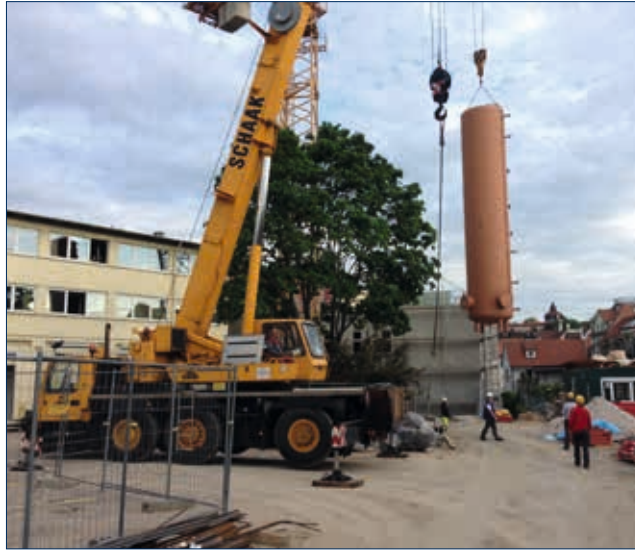
Einbringen des 10 m hohen, 30 m 3 großen zentralen Pufferspeichers
